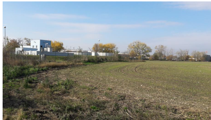
Obr. č. 6 Pohľad na ČOV a obhospodarovanú pôdu južne od záujmového územia
